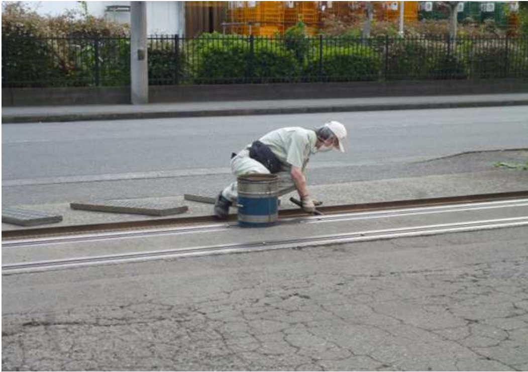
埼玉工場：排水溝掃除
